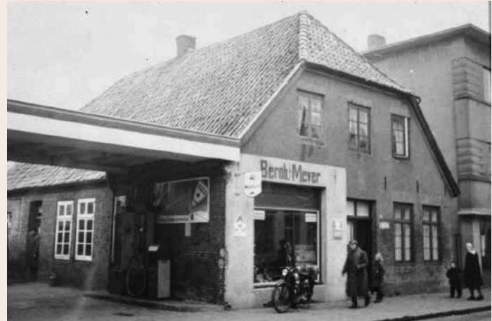
Dieses undatierte Bild entstand vor 1950 und zeigt unter dem Überdach bereits eine Zapfsäule.
