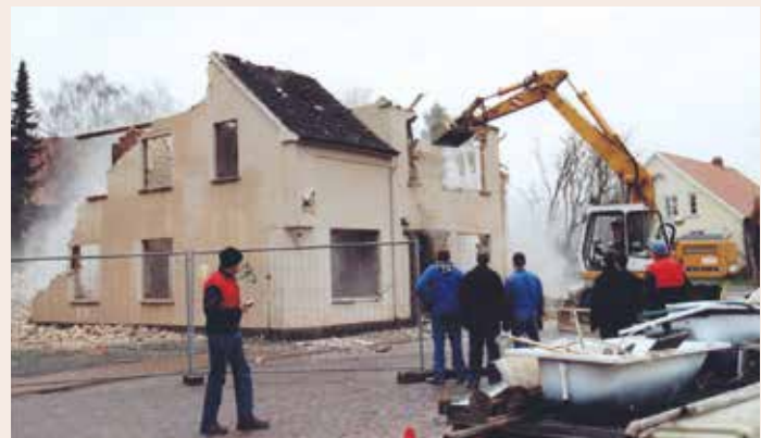
Am 13. März 2004 schaffte der Bagger Platz für das „Schulprojekt“.
