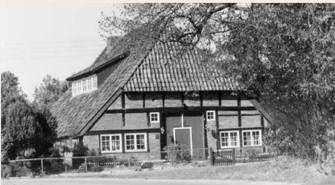
Eine jüngere, undatierte Aufnahme zeigt den Amtskrug bereits mit ausgebautem Dachstuhl.
