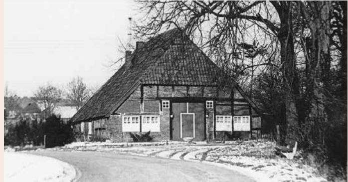
1973 wurde der Krug saniert und bot im Winter 1976 diese Ansicht.
