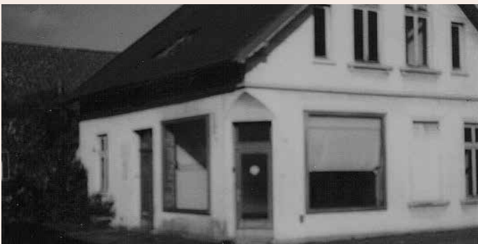
Das letzte bekannte Bild des Hauses kurz vor dem Abriss 1981.
