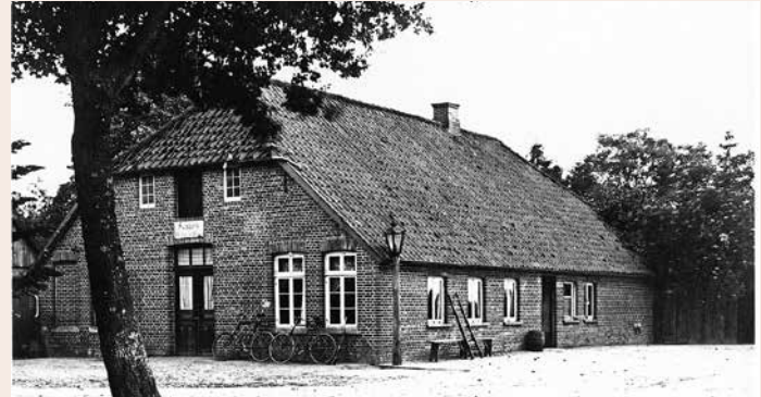
Diese undatierte Aufnahme zeigt das Haus bereits mit Dachpfannen. Vermutlich aus den 1920er Jahren.
