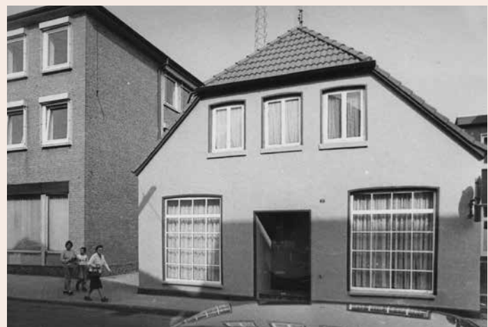
Diese Aufnahme von 1988 zeigt, dass das Haus Anfang der 1980er Jahre noch einmal grundlegend saniert wurde. Fassade, Dach und Fenster wurden ausgebessert, beziehungsweise ausgetauscht.
