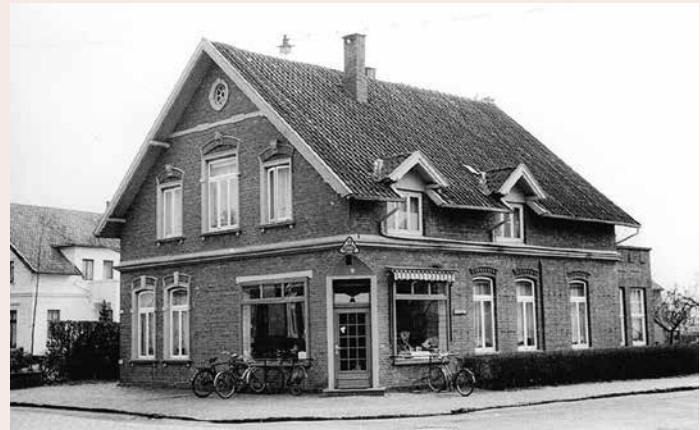
1951: Mit Orlik kam der erste nach außen sichtbare Umbau.
