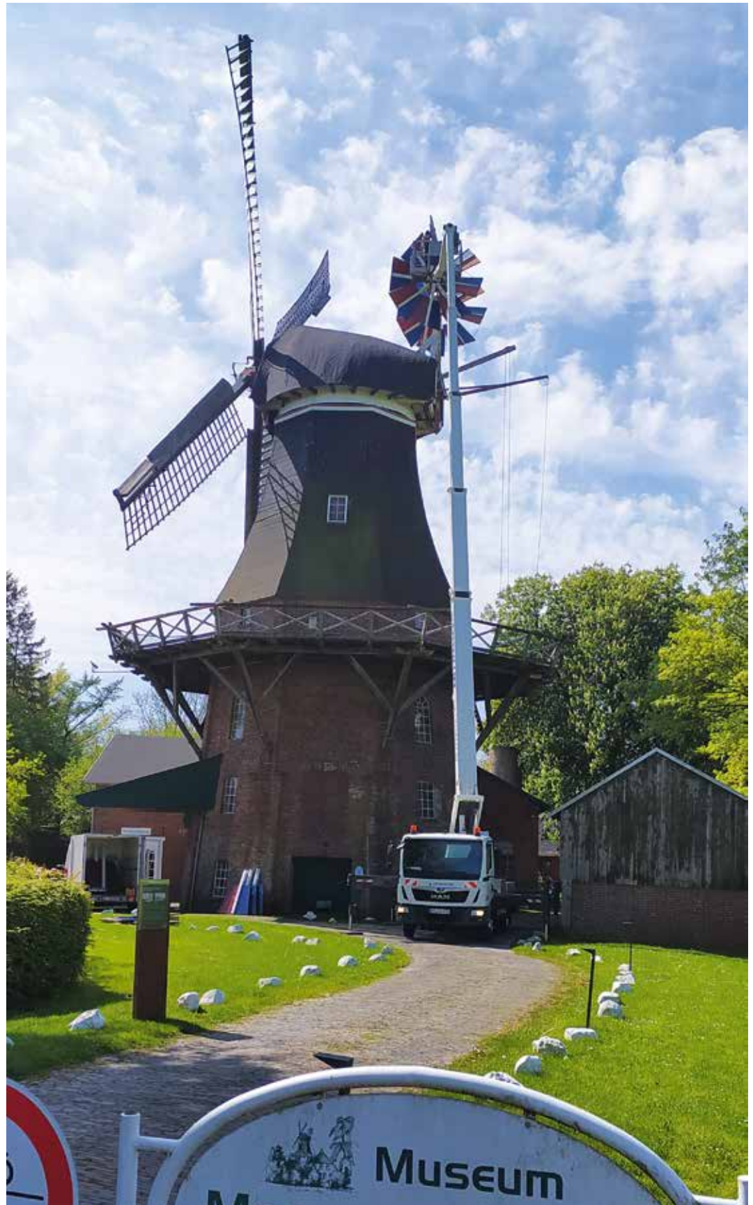
Mit einem auf 33 Meter Höhe ausfahrbaren Hubsteiger installierten die Fachleute aus Winsen-Luhe die insgesamt 16 Elemente an zwei Windrosen. Bilder: Lutz Timmermann
